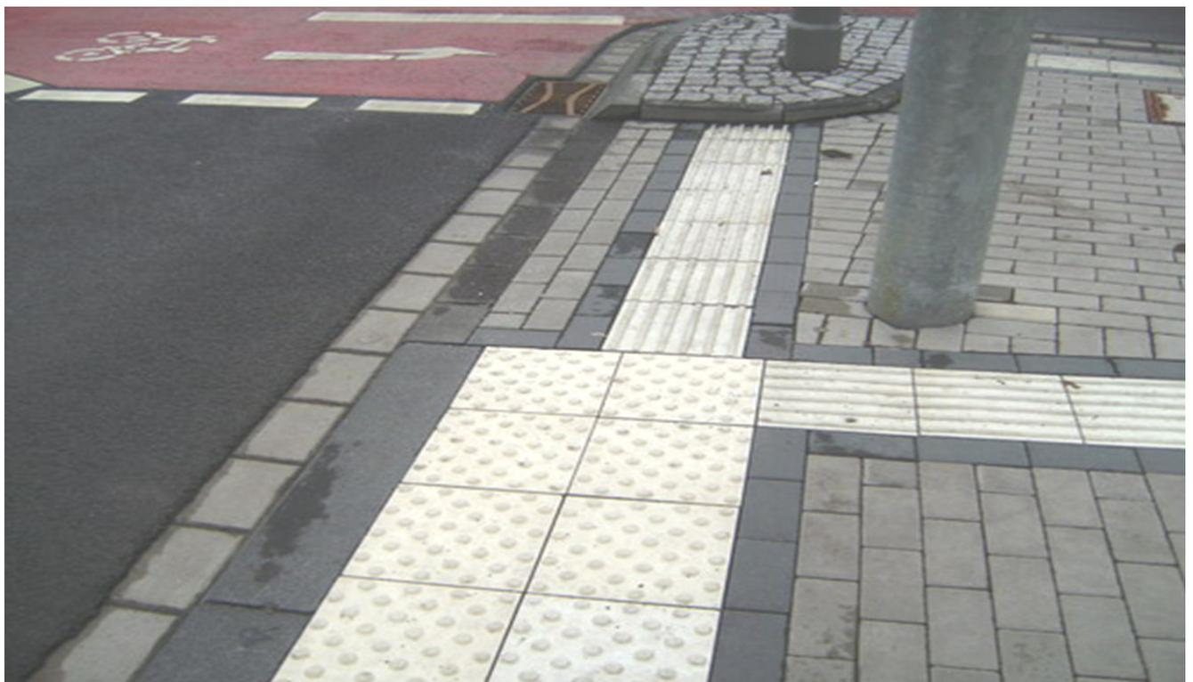
Rippenplatten Typ I kombiniert mit Noppenplatten Typ I in Kombination mit Begleitstreifen aus Pflasterplatten 10x20x8cm in anthrazit.
