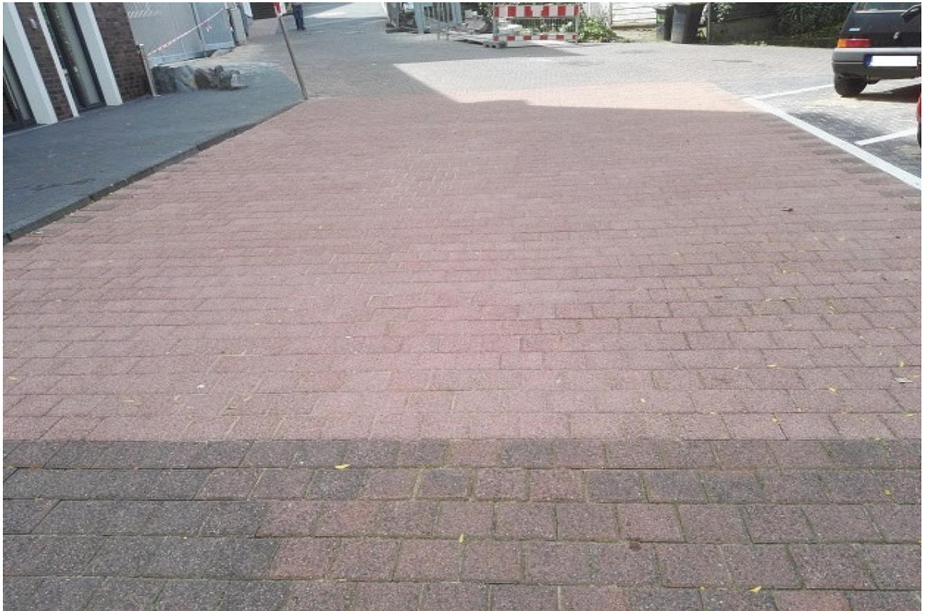
Ausbesserung in Wuppertal Milchstr. mit Pflaster 16-14-16cm Porphyrtrot im August 2017
