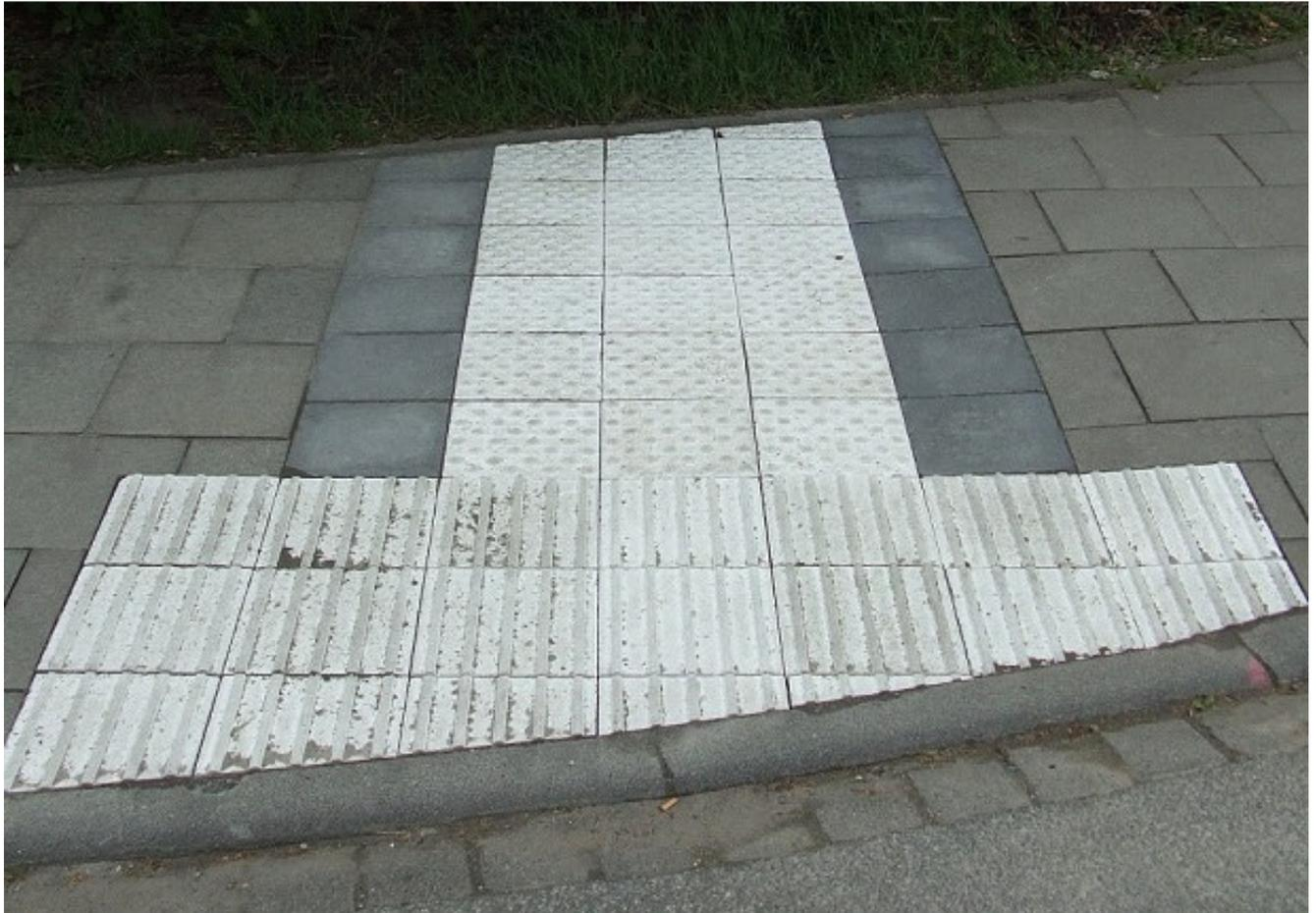
Rippenplatten Typ I kombiniert mit Noppenplatten Typ I in Kombination mit Begleitstreifen aus Pflasterplatten 30x30x8cm in anthrazit.
