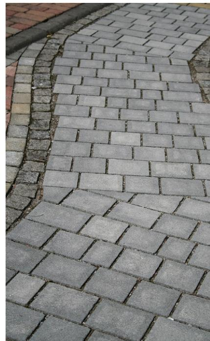
Basapor - MultiStone, scharfkantiges Fugenpflaster mit Verschiebsicherung und Sickerfunktion
