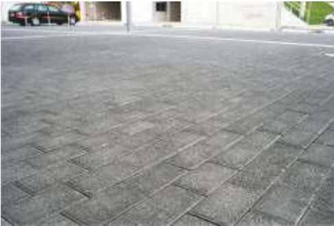
Öko-Basament-Pflaster 10/20/8 in anthrazit mit Basaltvorsatz
