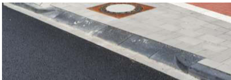
Die stabile Lösung für Einfahrtbereiche mit optimiertem Gefälle
