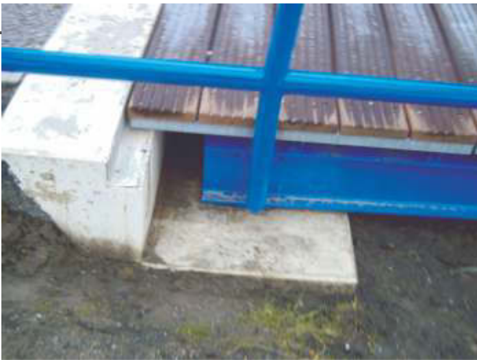
Für jedes Problem die passende Betonlösung. Hier: Brückensteine zur Aufnahme einer Fußgängerbrücke.
