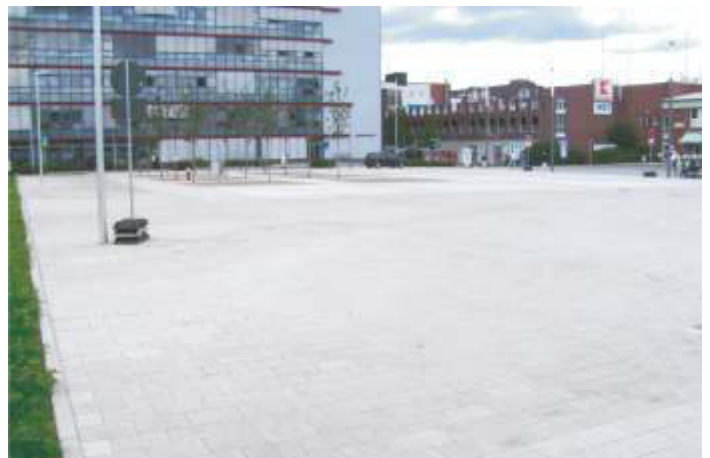
Pflasterplatte für Schwerlastbereiche 30/20/12 in grau
