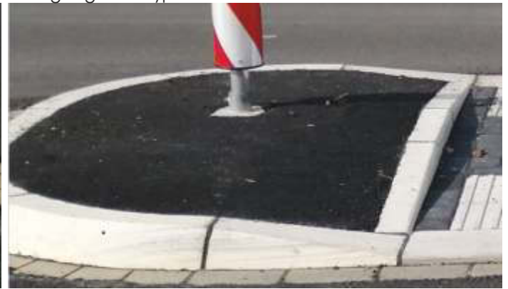
F-10 Radien 20/25/78 cm mit Querungs- übergangsstein Typ IIb von Tastbord auf F-10 Kurvenstein
