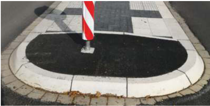
F-10 Flachbordstein mit F-10 Radien 20/25/78 cm, Radius = 1,0 m, konvex
