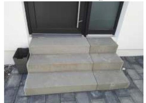
**948 Blockstufen, in Sichtbeton mit strukturierter rutschsicherer Oberfläche, Rutschfestigkeitsklasse R13, 1 Längsseite gefast**
