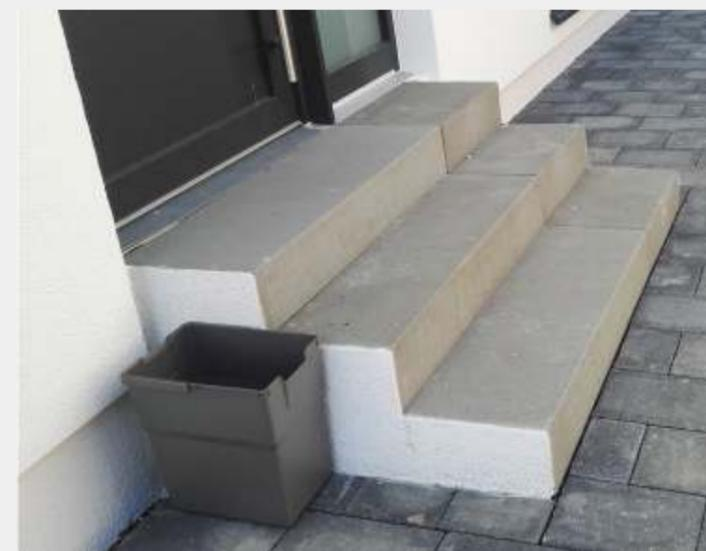
Blockstufen 15/35/75 cm mit Vorsatz. Maschinenfertigung, rundum gefast.
