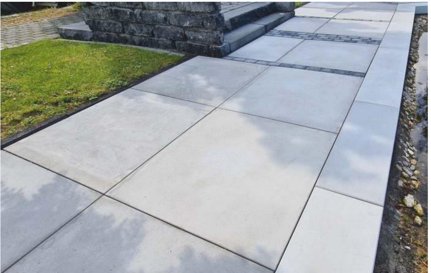
Architekten-Platten 100/100/4 cm und Architekten Stufen 16/35/100 cm in grau, Oberfläche ruvido
