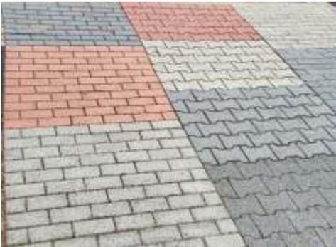
Öko-Basament-Pflaster mit Basaltvorsatz ist ein haufwerksporiger Splitt-Beton und somit wasserdurchlässig.
