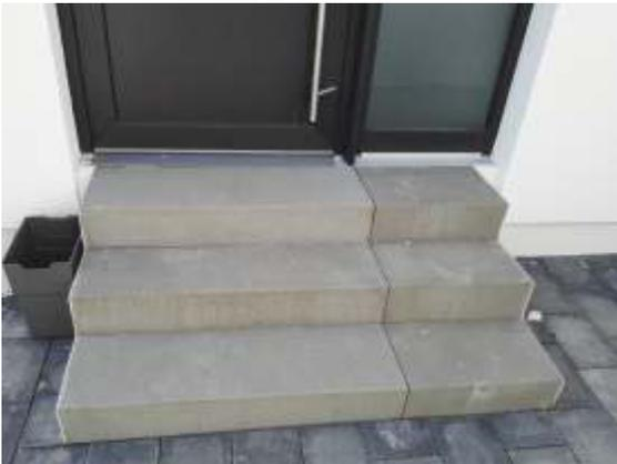
Ergänzend zu unseren etablierten Maschinenstufen in 15/35/100 und 50 cm fertigen wir die neuen Stufen in Maschinenfertigung im Maß 15/35/75 cm in grau u. anthrazit mit Vorsatz. Begründet ist die Fertigung u.a. in der Nachfrage an 125er Baulängen, die sich nunmehr mit 2 Stufen á 50 und 75 cm realisieren und leichter Versetzten lassen. Auf diesem Bild zeigt sich eindrucksvoll, wieso wir 3 verschiedene Längen fertigen.
