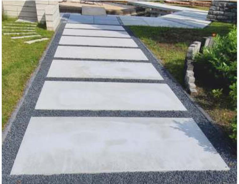
Großformatige Architektenplatten 200/100/4 cm ruvido, grau großzügig umgeben von Kies als Versickerungsmöglichkeit
