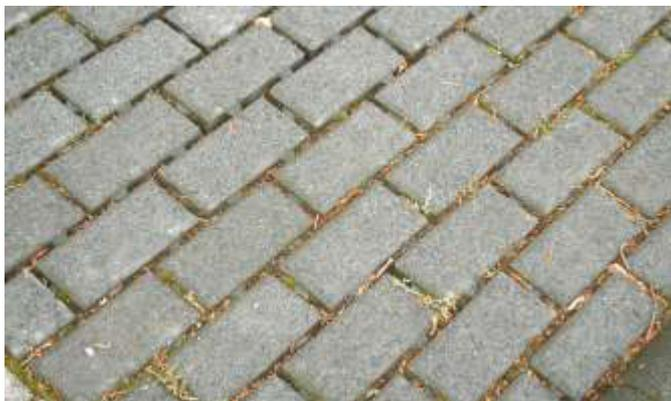
Drainfugen-Pflaster mit 1 cm Pflasterfuge durch 1 cm
