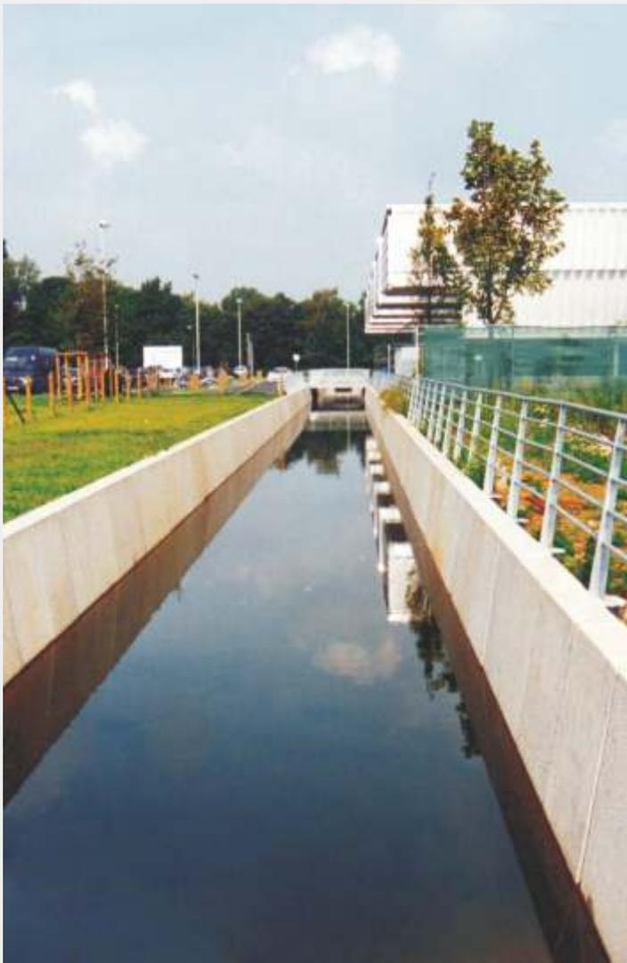
Winkelstützen für den Wasserkanalbau
