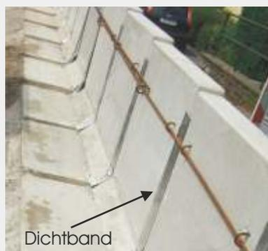
Wir empfehlen die Verwendung von wasserundurchlässigem Dichtband. Dieses können Sie über uns beziehen.
