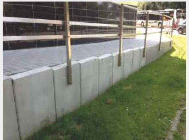
Winkelstützen in 50 cm Baulänge stufig eingesetzt zur
