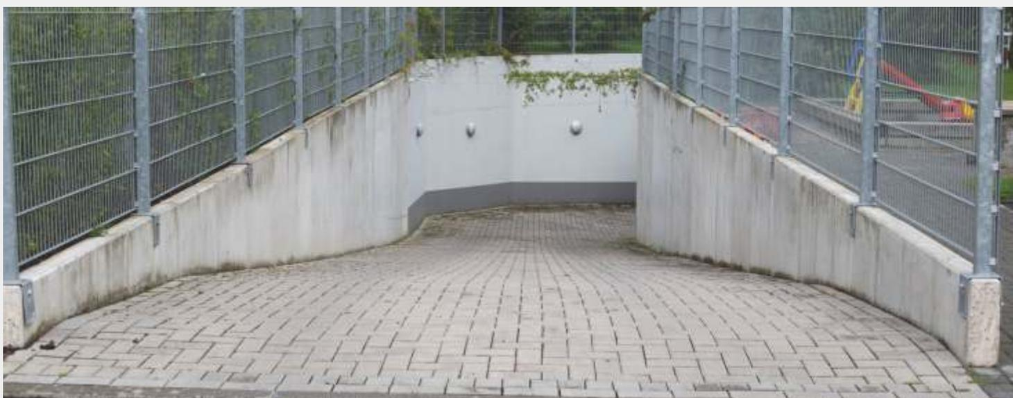
Winkelstützen für den Bau einer Tiefgaranzufahrt
