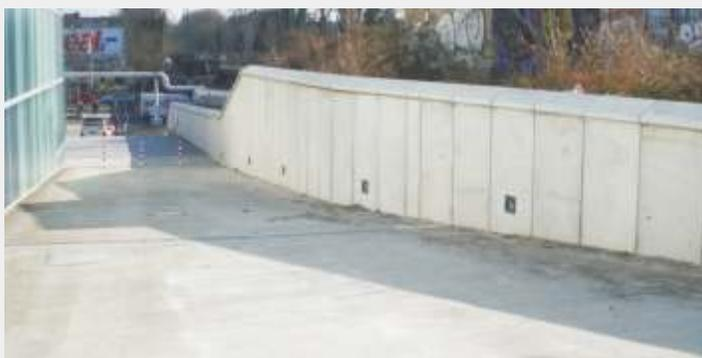
Winkelstützen mit Beleuchtungsvorbereitung und Mauerabdeckung (Sonderanfertigung)
