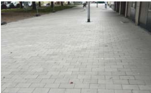
Pflasterplatte 30/20/12 cm, grau, scharfkantig Objekt in Duisburg, Kühlenwall.
