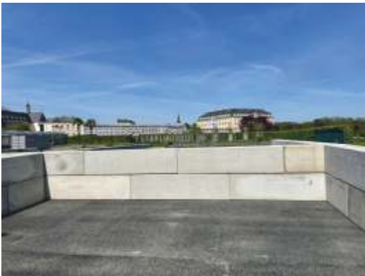
Das Böcke Jumbo-Blocksystem in 60 cm mit oberen Abschlussblöcken.
